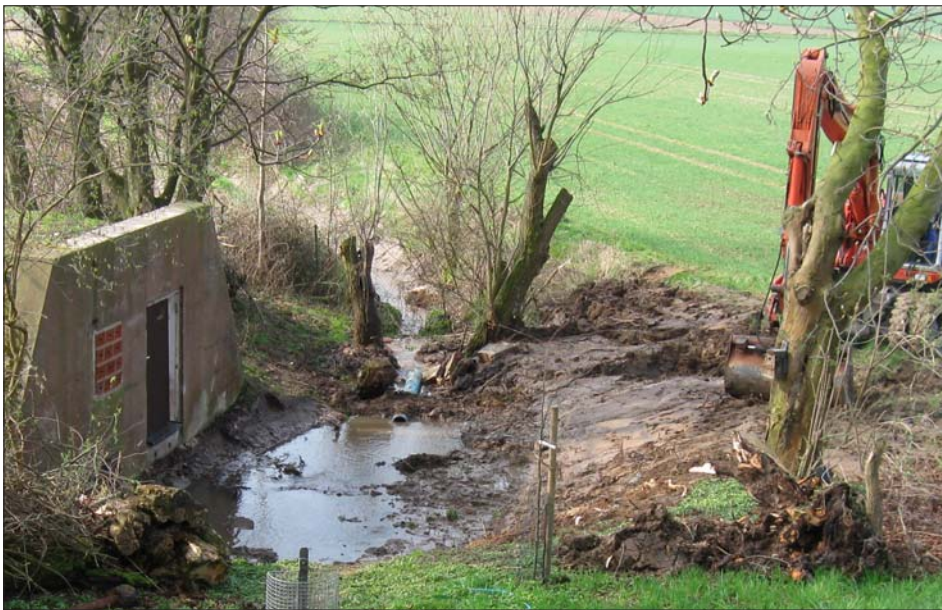
Die maroden Quellfassungen aus Beton der ehemaligen Wassergewinnung (oben) werden durch einen naturnahen Quelltümpel ersetzt (unten).
