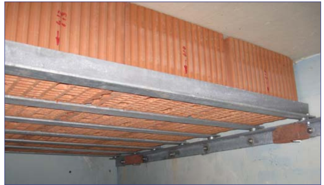
Hohlblockziegel im Winterquartier
