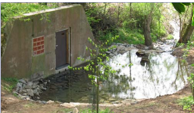
Renaturierter Quellbereich mit ableitendem Graben zum Bornumer Bach
